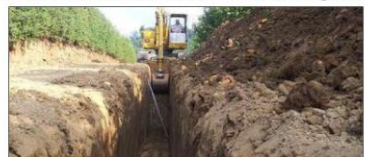
Installazione delle condotte
